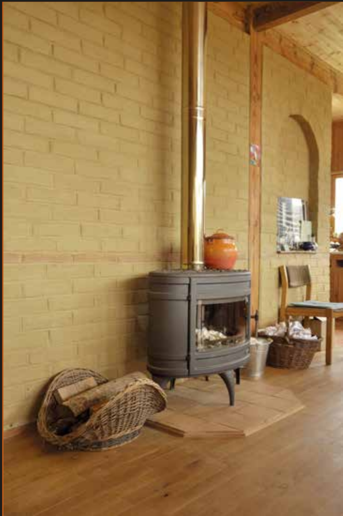
Briques de terre crue comme éléments d'inertie derrière un poêle à bois (source: Sylvain Moreteau)
