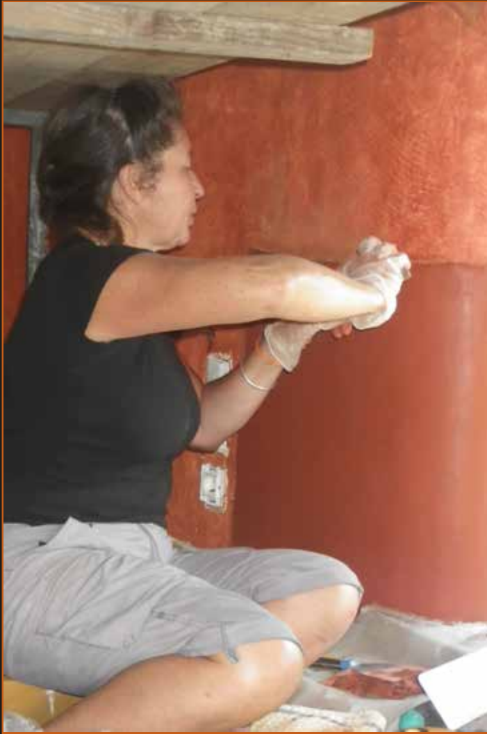
Michèle Bailly réalisant un enduit chaud (source: Dominique Rigaud)
