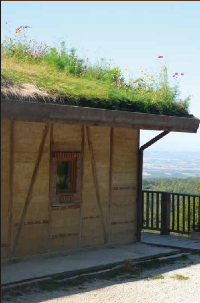
Toiture prairie dans le Minervois (source: Sylvain Moreteau)
